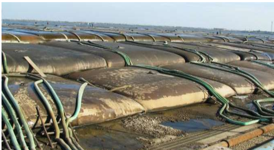
图 2.2-5 土工管袋脱水
